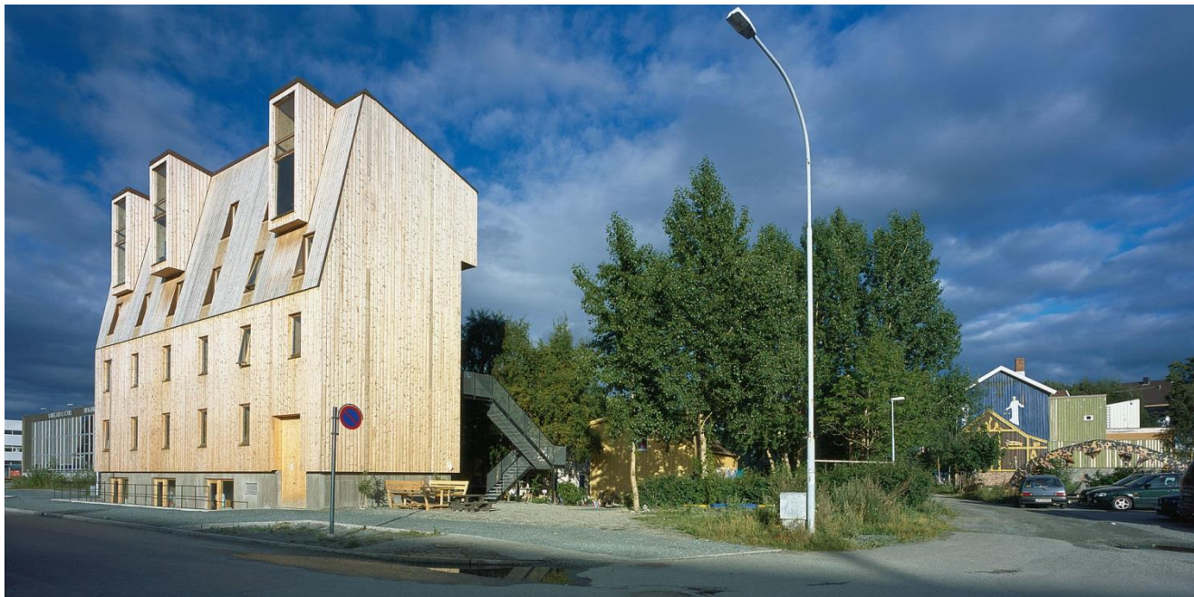
Hybelbygg utført i massivtre fra Trondheim, teikna av Brendeland og Kristoffersen arkitektur
