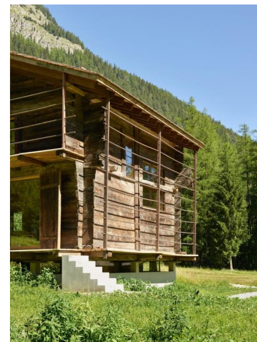
Ombygnad av uthus med gjenbruk av gamle konstruksjonar og bygningsdelar. Bygnad frå Sveits, teikna av Savioz Fabrizzi Architectes
