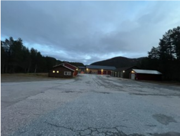
Figur 25: Kontorbygga til Otra kraft på Holsmoen
